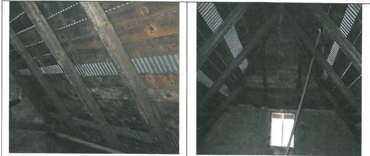
Foto. 11. Elementy więźby dachowej - krokwie
