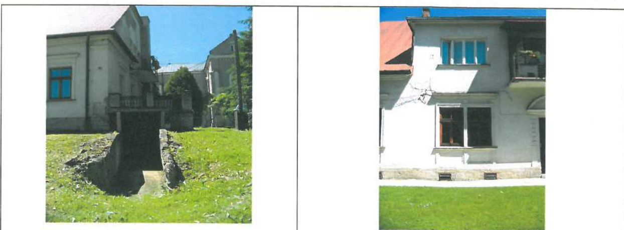
Foto. 6. Widok elewacji budynku
