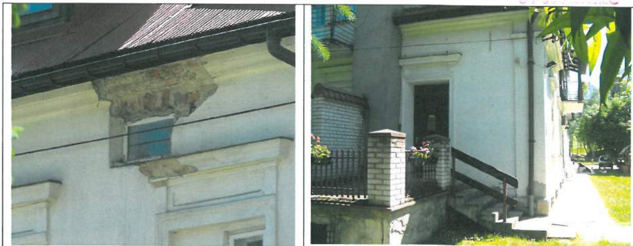
Foto. 4. Widok ścian budynku
