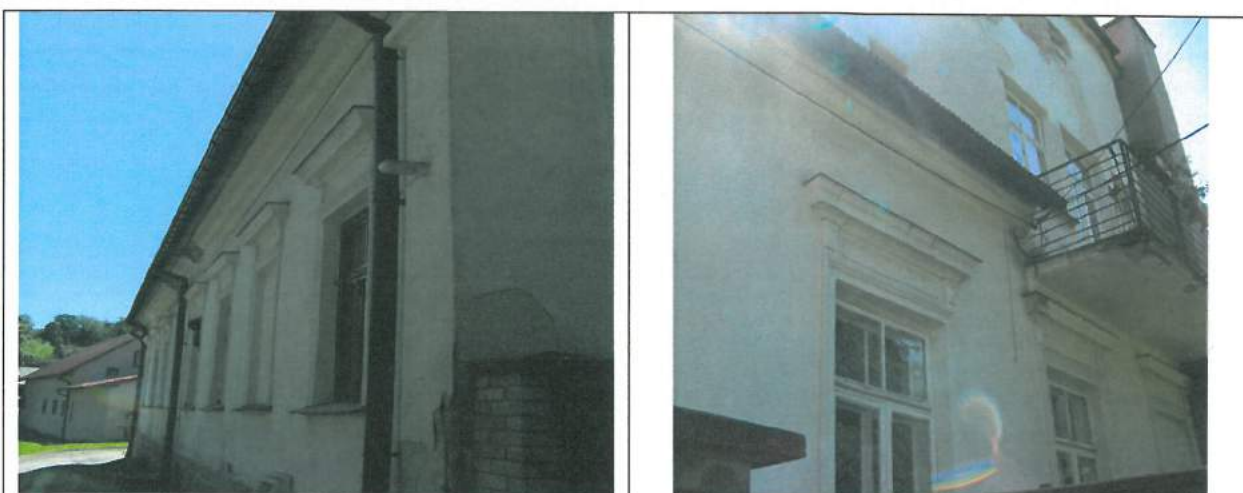
Foto. 2. Widok ścian budynku – brak zarysowania i pęknięć
