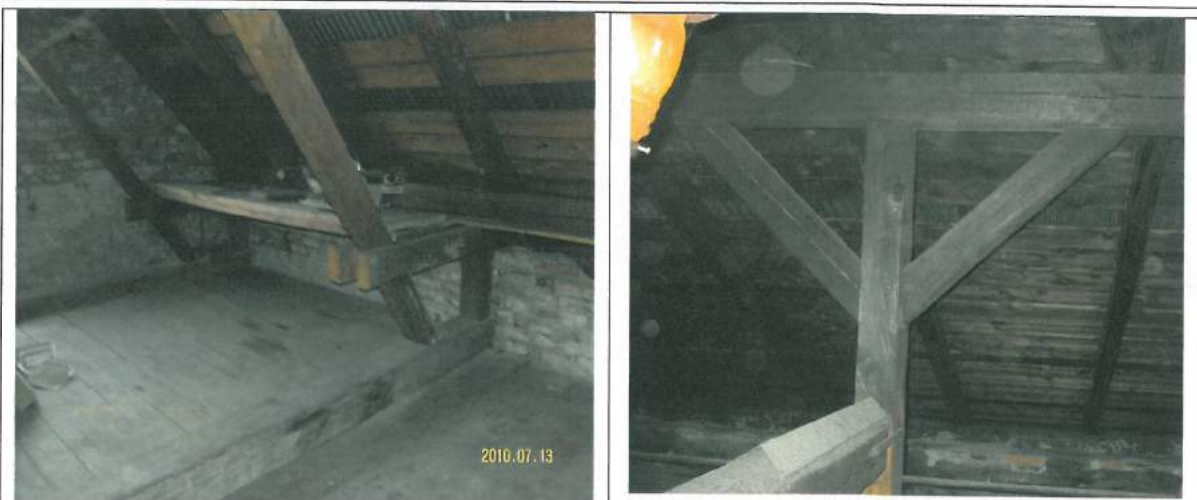
Foto. 13. Elementy więźby dachowej – krokwie, murlata, miecze
