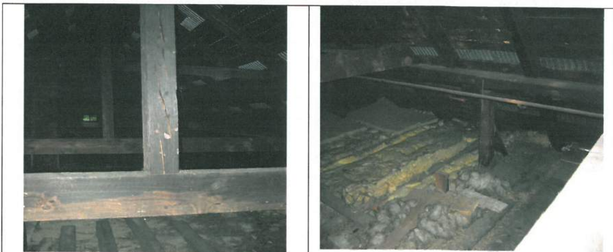
Foto. 12. Elementy więźby dachowej – słup, murlata
