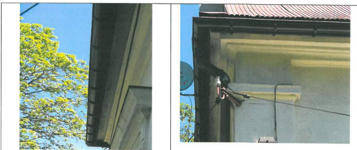
Foto. 5. Odwodnienie dachu – rynny i rury spustowe
